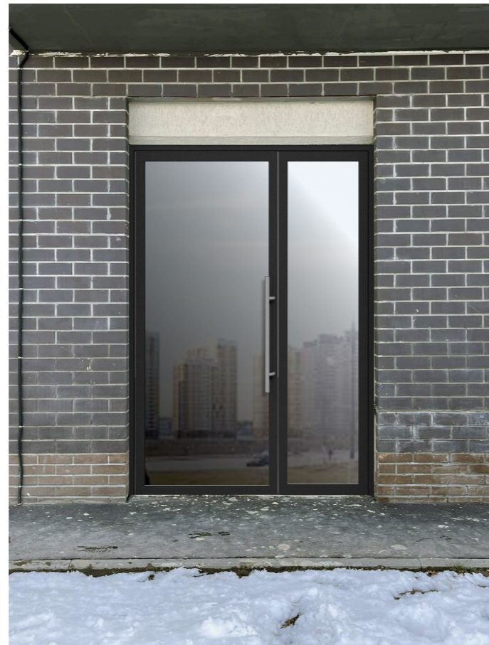
Ось 1\В-Г. После переустройства.
